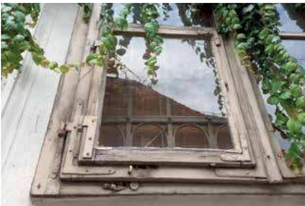
Abb.19: Restaurierfähiger Zustand eines Bestandsfensters an der barocken Fassade des ehem. Palais Hohenrain in der Grazer Kinkgasse. Die Instandsetzung konnte jüngst fertiggestellt werden.
