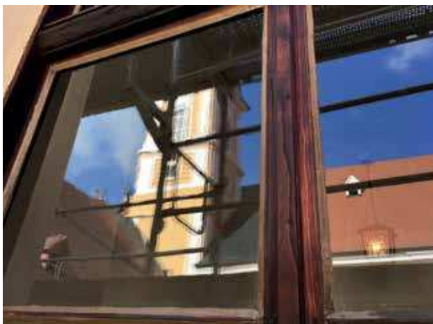
Abb.16: Vergleich der Reflexion eines Restaurierglases (links) und eines herkömmlichen Floatglases (rechts) am Beispiel von Fensterflügeln im alten Konventhof von Stift Rein.
