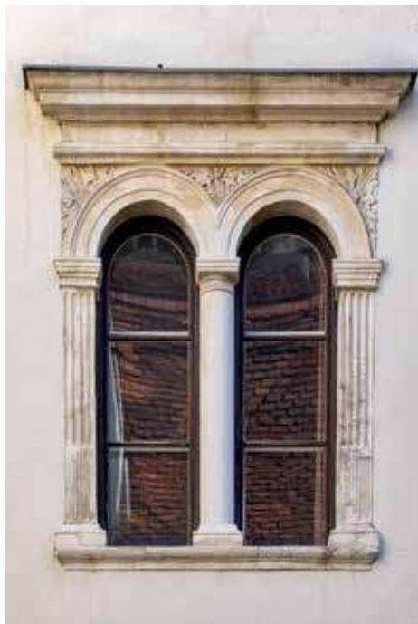
Abb.3: Doppelarkadenfenster aus der Renaissance, Sackstraße 12.
