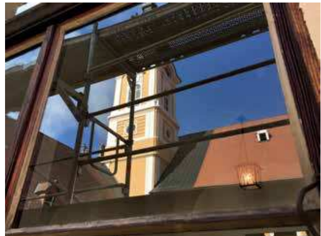
Abb.16: Vergleich der Reflexion eines Restaurierglases (links) und eines herkömmlichen Floatglases (rechts) am Beispiel von Fensterflügeln im alten Konventhof von Stift Rein.
