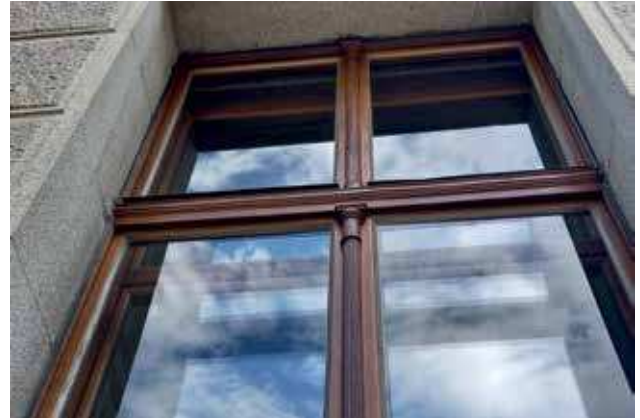
Abb.18: Geringfügig pigmentierter, nicht deckender Ölanstrich der restaurierten, historischen Fensterausstattung aus Slawonischer Eiche des Österreichischen Parlamentsgebäudes in Wien.
