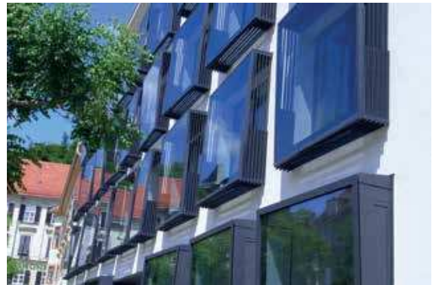
Abb.8: Das Kastenfensterprinzip in zeitgenössischer Form weiter entwickelt, Karmeliterhof.
