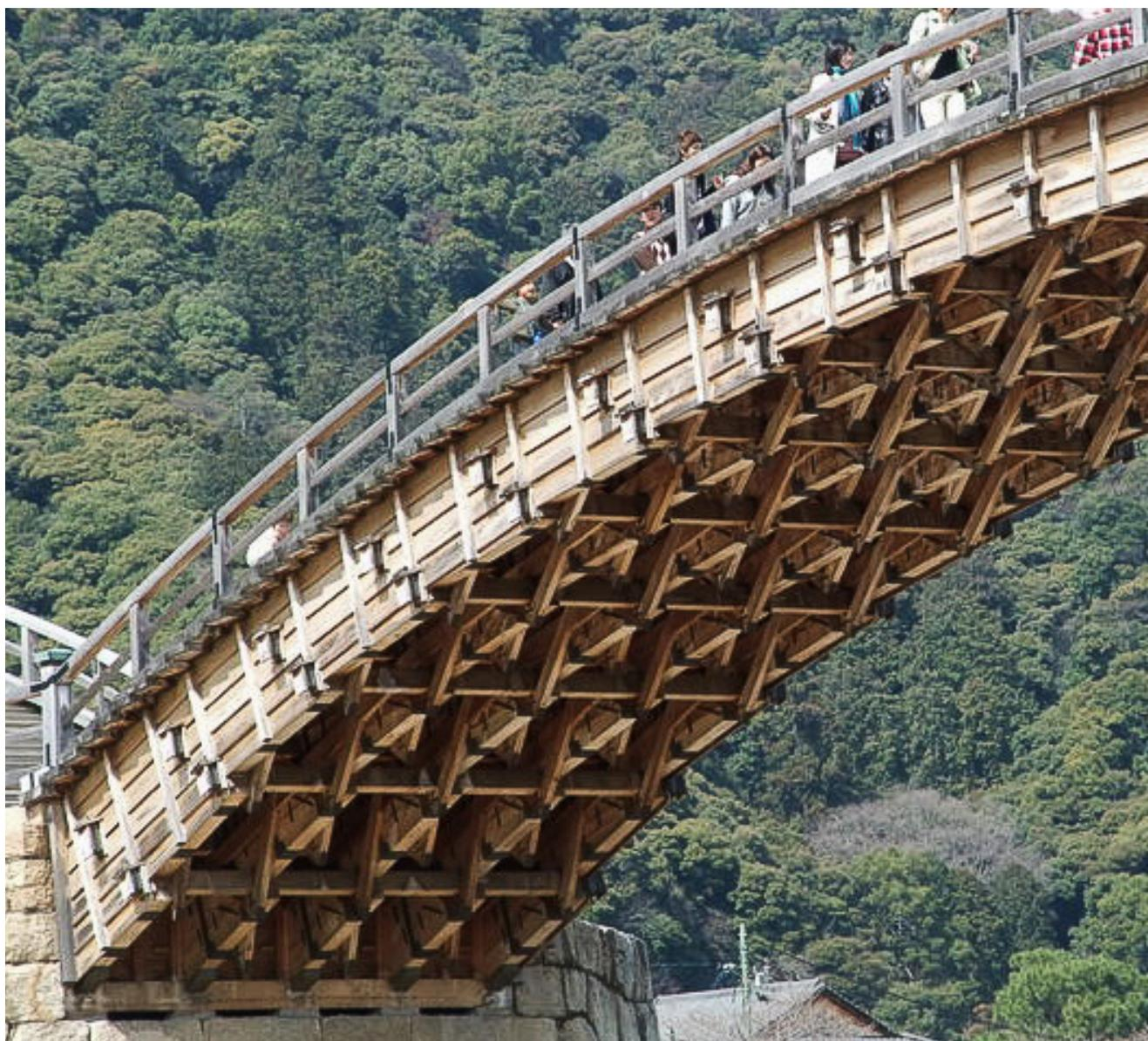
Oberfläche folgt. Man muss also mehrfach über die Bogenform auf- und absteigen, was bei den steileren Abschnitten auch Stufen erforderlich machte.
