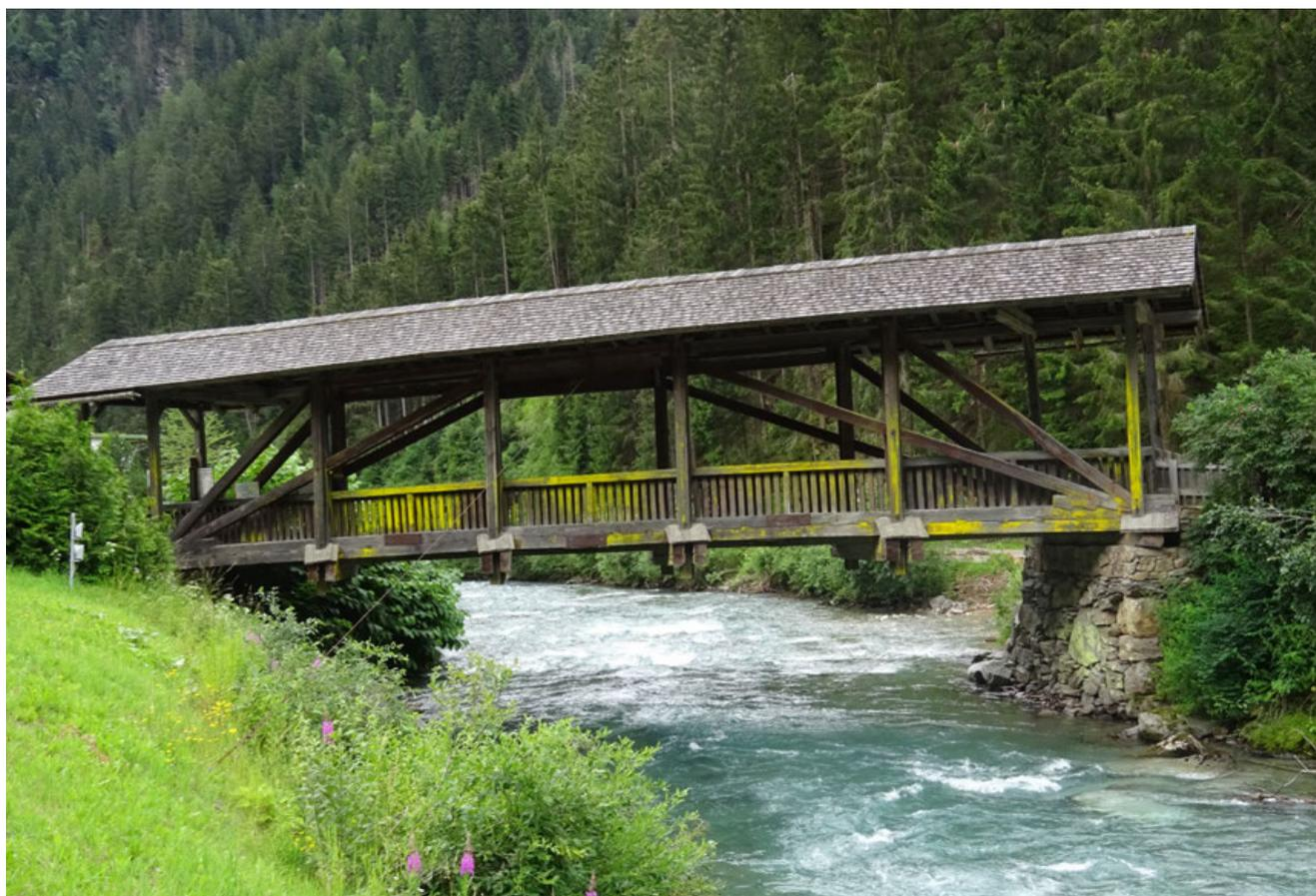
An ihnen hängt quasi die Fahrbahn der Brücke, die zusätzlich bis zu 9 t Gewicht auch an Nutzlast noch aufnehmen kann. Die Brückenkonstruktion wird aber noch komplexer, weil sie nicht geradlinig über die Schwarzach geführt wurde, sondern etwas abgewinkelt ausgerichtet ist. Daher ist die gesamte Tragkonstruktion wie ein Parallelogramm im Grundriss verschoben. Nur die Dachkonstruktion schließt im Grundriss annähernd rektangulär die Brücke ab.
