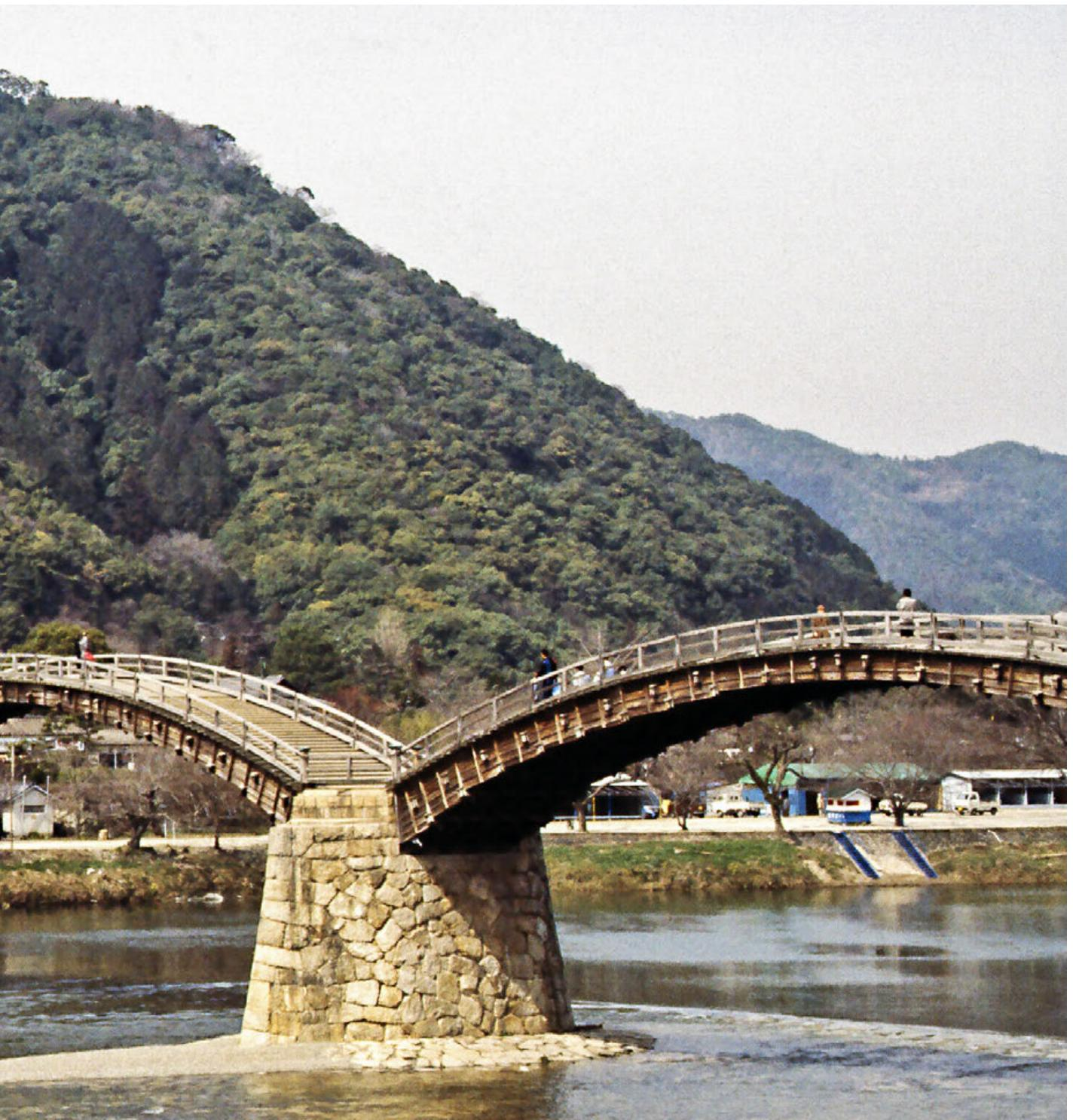
Brücke hatte und hat damit eine gewisse konstruktive Ähnlichkeit mit der Konstruktionsweise vieler römischer Brücken, bei denen auch oft die Brückenpfeiler aus Stein errichtet wurden, die Segmentbögen dazwischen aber aus Holz. Der wesentliche Unterschied zwischen den beiden Brückentypen ist, dass bei der römischen Brücke die Nutzfläche geradlinig alle Bogenformen ausglich, während die Nutzfläche der japanischen Brücke den Bogenformen der Segmentbögen an der begehbaren
