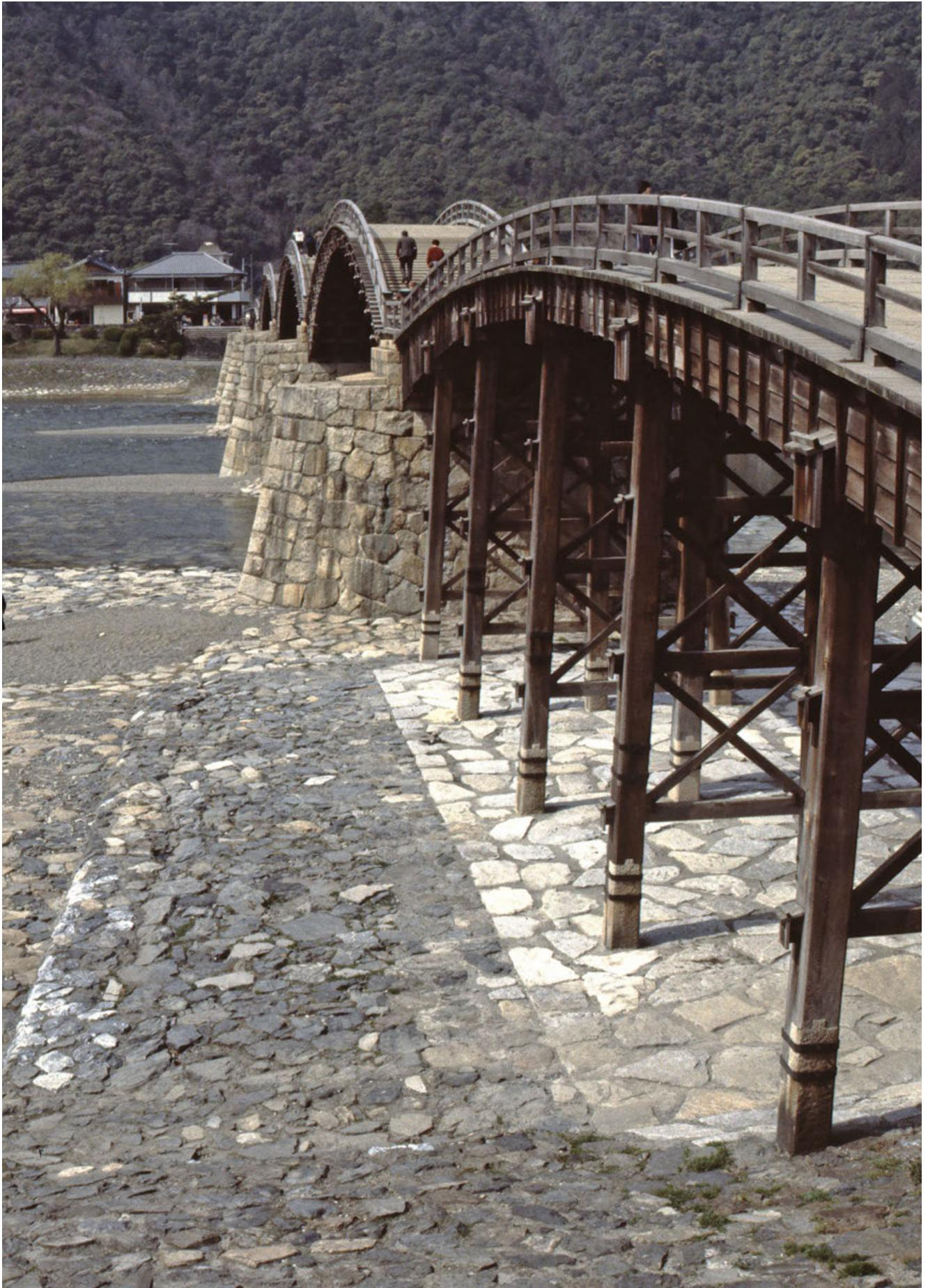
35,10 m und haben eine lichte Stichhöhe von 13,30 m über dem Fluss bei normalem Wasserstand. Um ein Desaster wie das nach ihrer ersten Errichtung 1673 zu vermeiden, wurden die Steinelemente der gemauerten Pfeiler an der bugförmigen Spitze mit eisernen Doppelschwalbenschwänzen zusammengehalten. Nach ihrer Fertigstellung durfte die Brücke zunächst nur vom Auftraggeber und von Privilegierten benutzt werden, später auch von allen anderen Japanern aus der Stadt Iwakuni.
