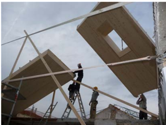
Figure 3. Installation of the pre-fabricated roof elements. Photo: kämpfen für architektur ag
