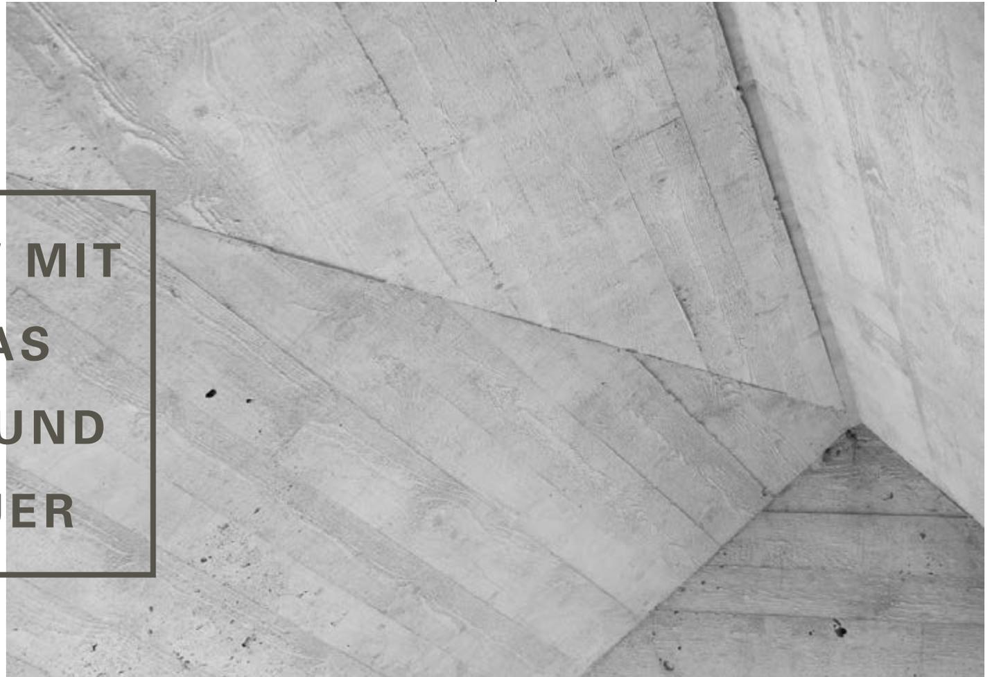
Abb. 35: Ebenenbündel ausgehend aus einem Trägerpunkt bestehend aus einer gefalteten Dachfläche, einer geraden Dachfläche und einer Giebelseite im Haus 36 von MBA/S Matthias Bauer Associates
