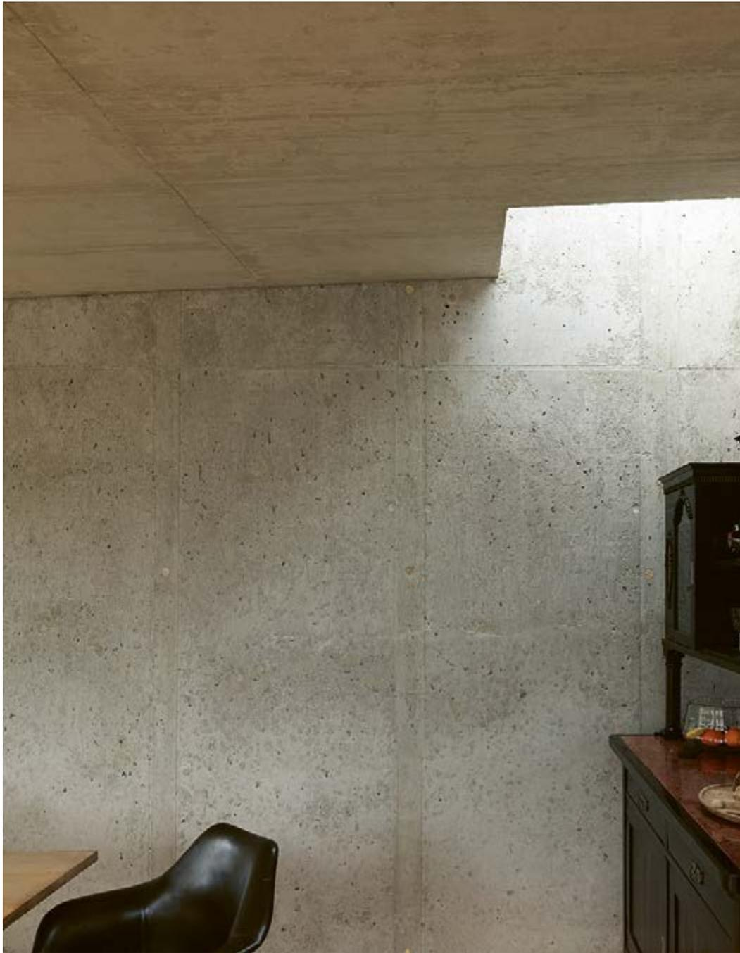
Abb. 58: Dämmbetonwand und Oberlichter
