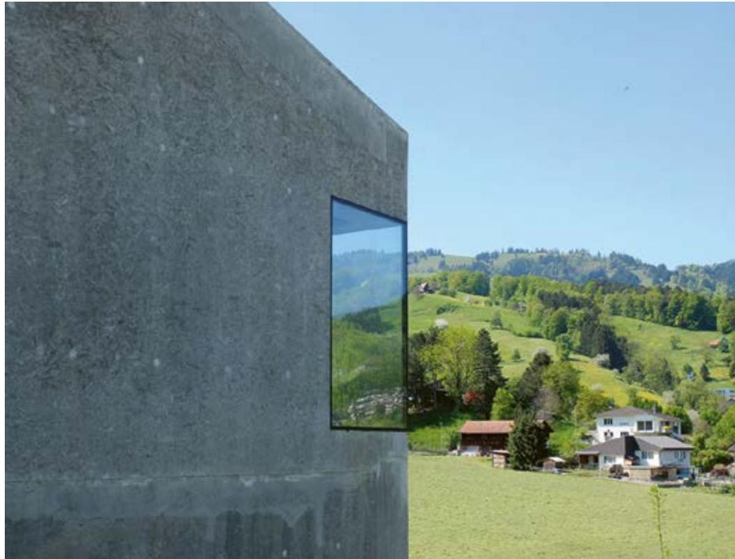
Abb. 41: Hanghaus, Altstätten, von Himmelhoch. Außenbündig eingeklebte Dreifach-Verglasungen.
