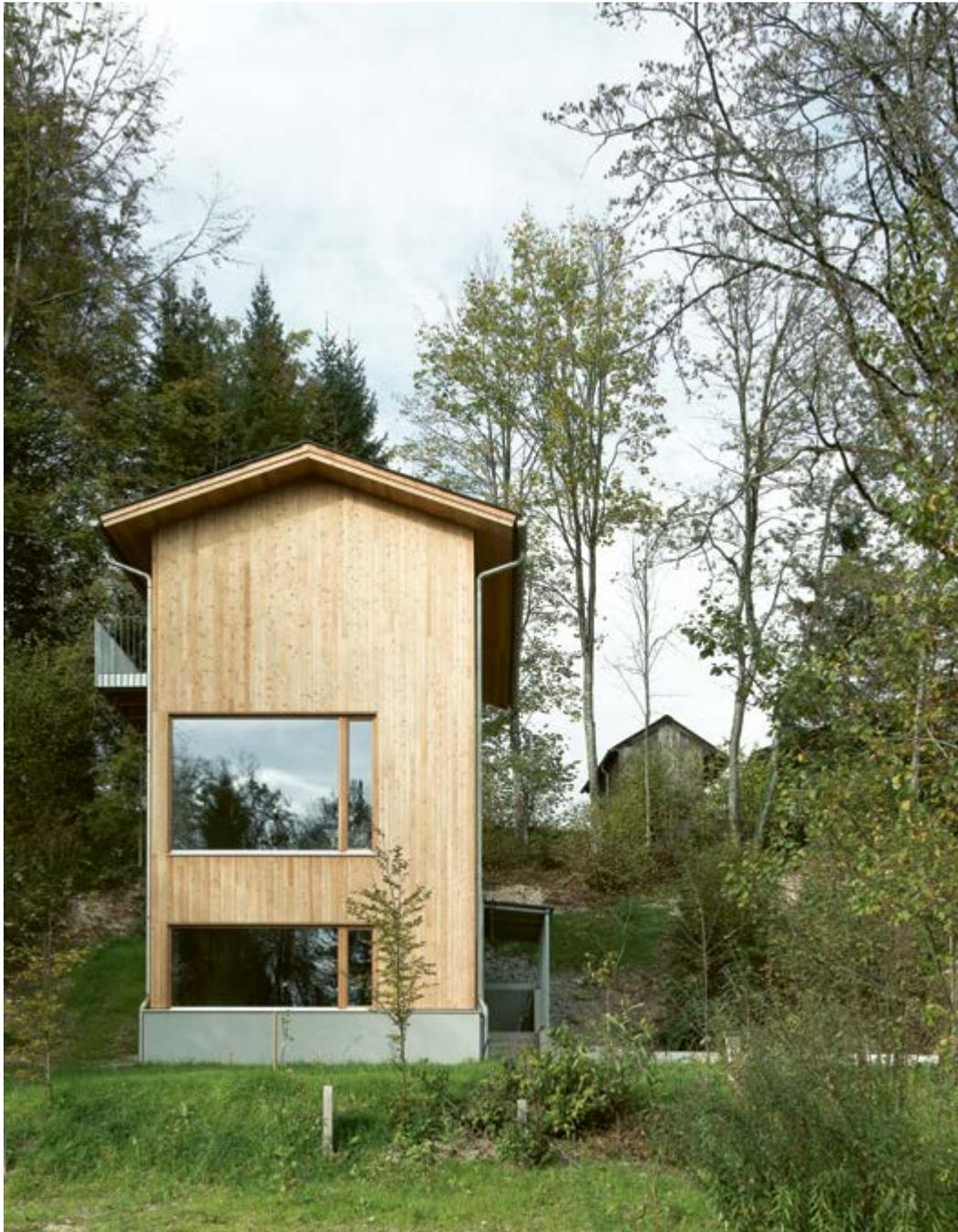
Abb. 08: Moderne Übersetzung klassischer Bauformen mit einschichtiger Massivholzaußenwand im Haus H32 von LP architektur
