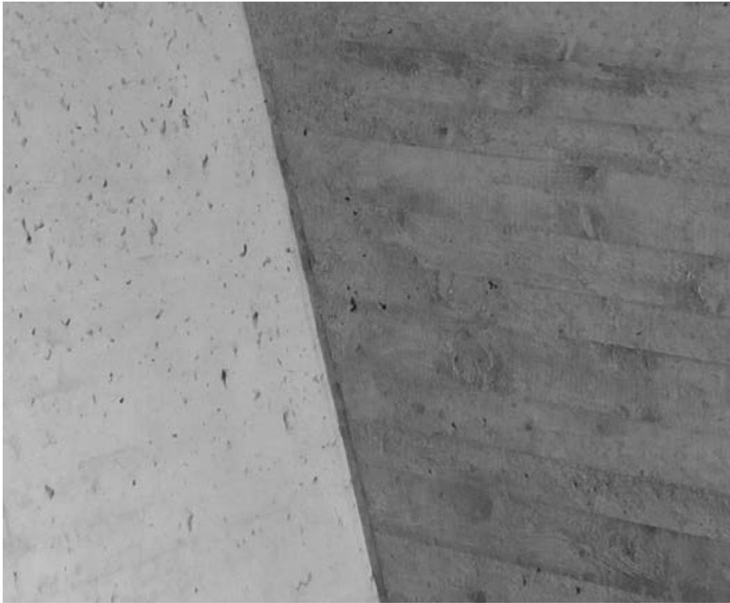
Abb. 17: Innenecke einer Leichtbetonwand; links eine geneigte Fläche mit mehr Lufteinschlüssen
