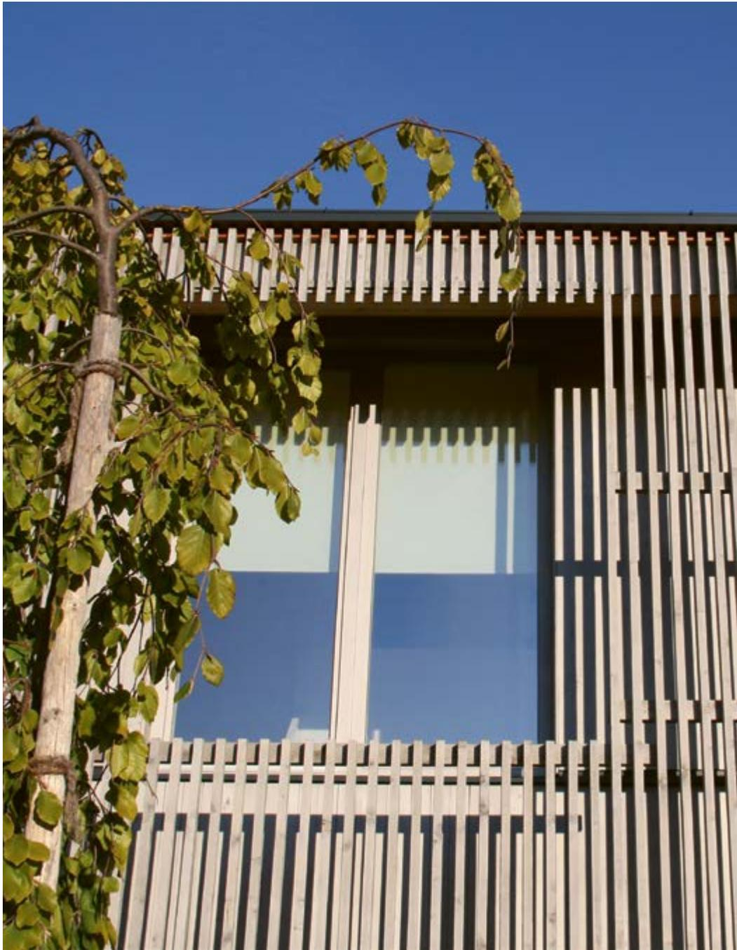
Abb. 49: Die zwei Ebenen der Fassade: die tragende und dämmende Massivholzwand aus Brettsperholz und davor liegend die offene Lärchenholzschalung für Witterungs- und Sichtschutz
