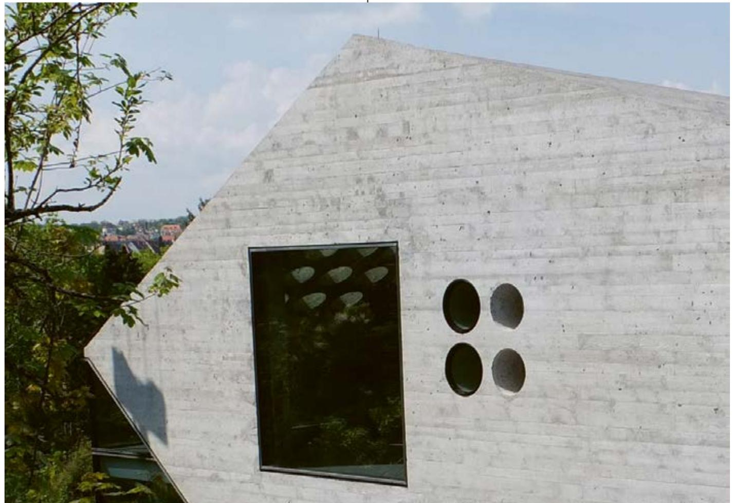
Abb. 39: Haus H36, Stuttgart, von MBA/S. Die runden Fenster wurden mittels Kernbohrung angelegt.
