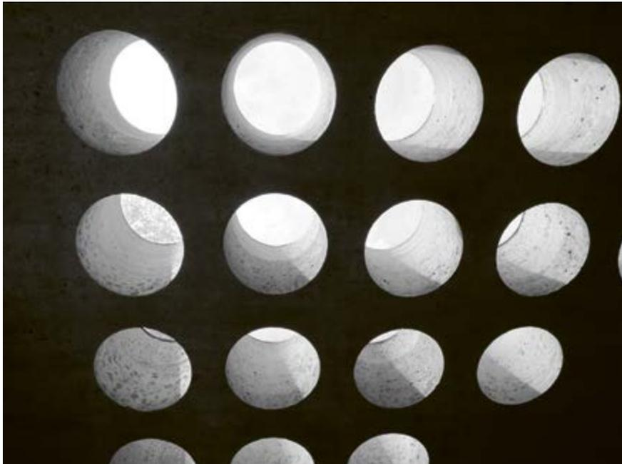
Abb. 38: Fenster-Kernbohrungen im Haus H36
