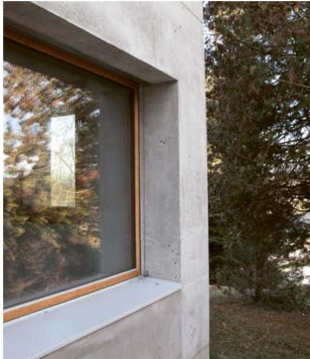
Abb. 64: Tiefe Fensterlaibung in monolithischer Bauweise
