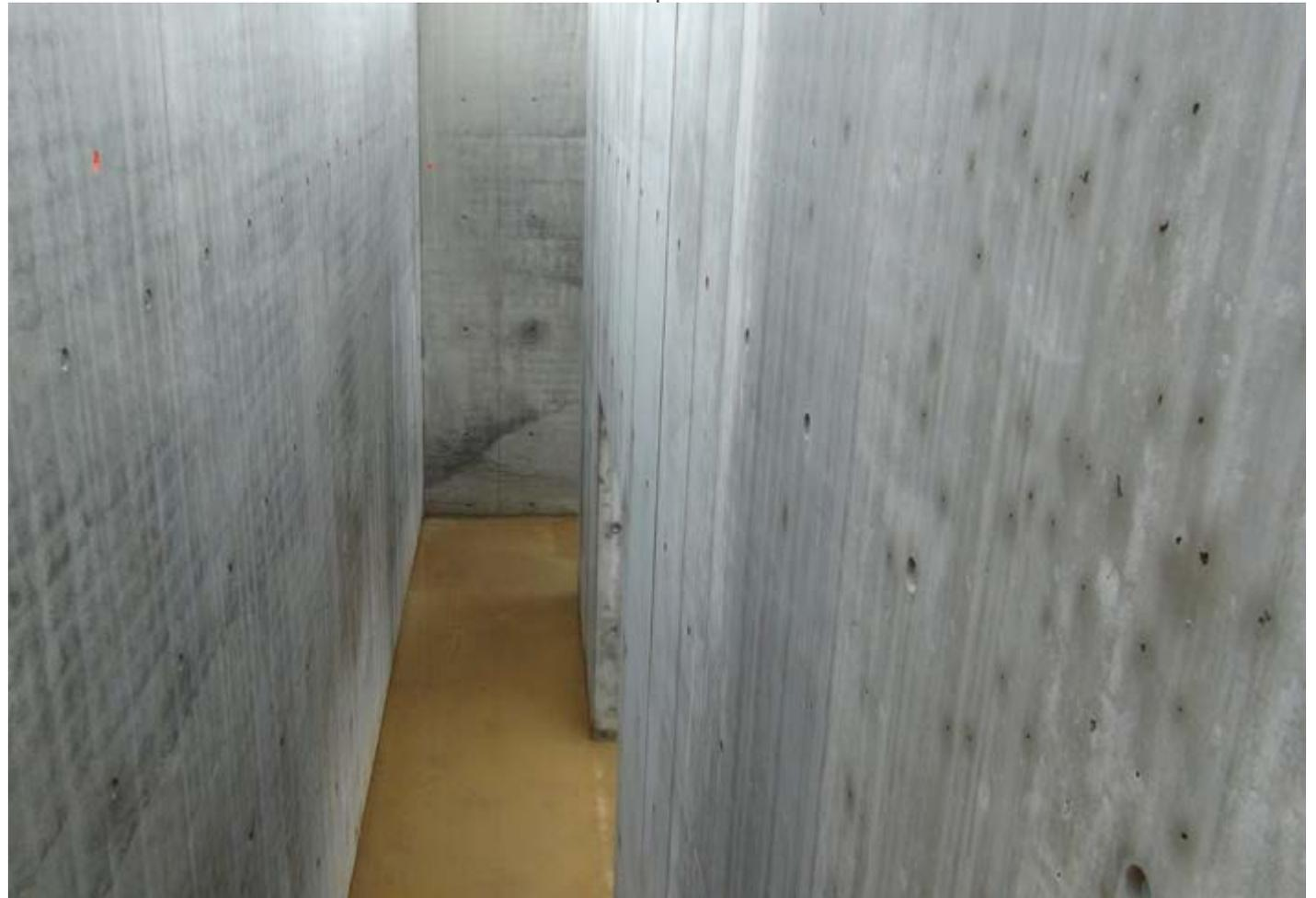
**Abb. 26:** Verbergen von Fugen in den Schalungssystemen macht monolithisches Bauen sehr technik- und arbeitsintensiv und somit teuer
