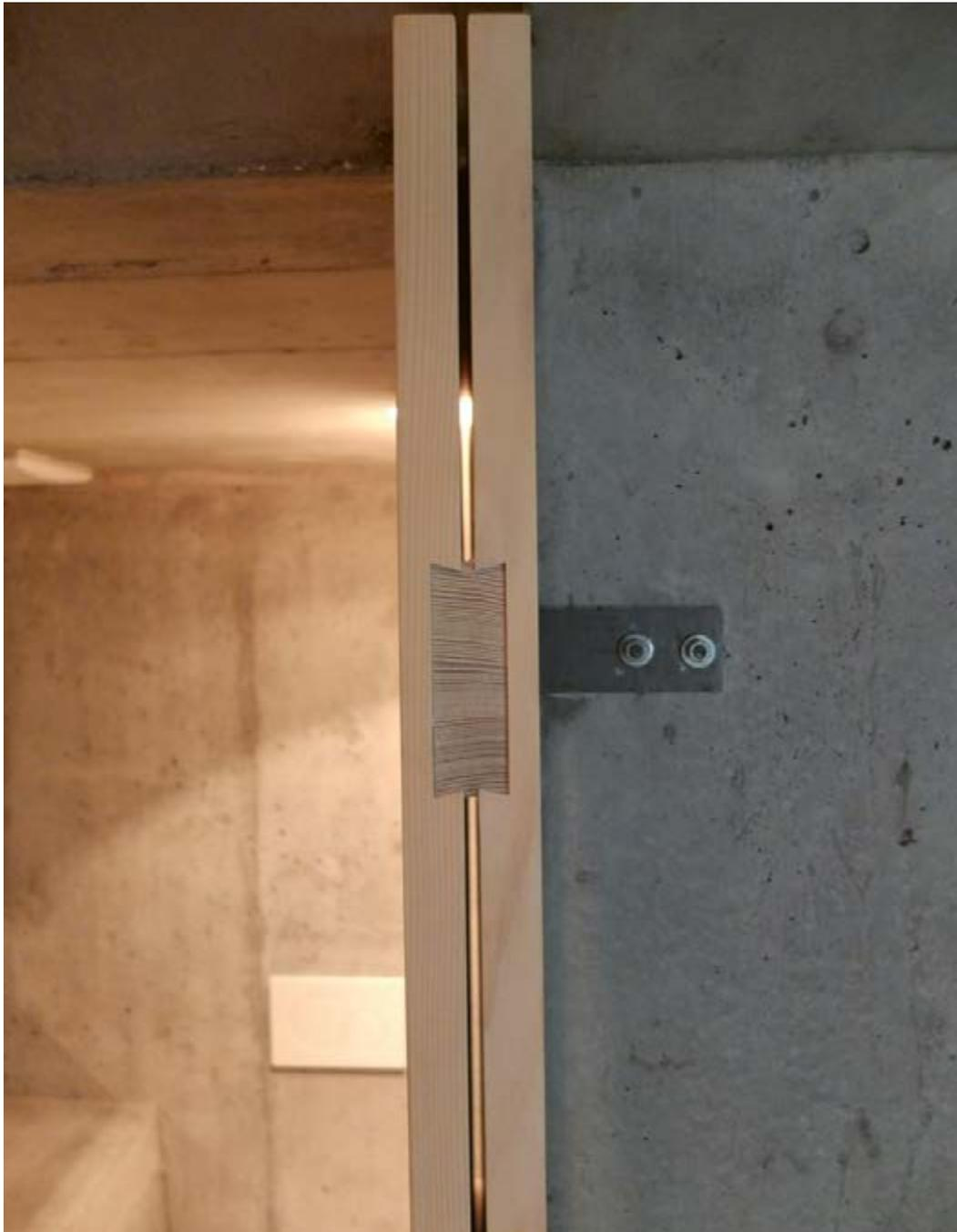
Abb. 90: Doppelter Schwalbenschwanz als mechanische Holzverbindung
