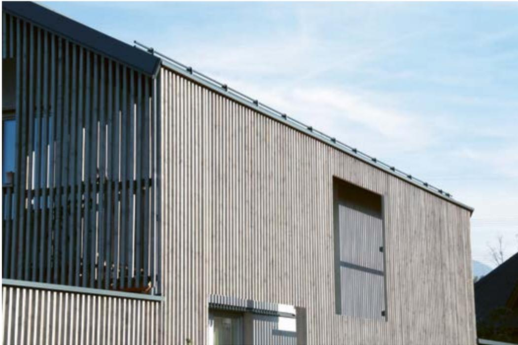
Abb. 54: Die Lärchenholzlatung als äußere Fassadenebene zieht den Baukörper zusammen und gibt ihm gleichzeitig eine Tiefe in der äußeren Schicht
