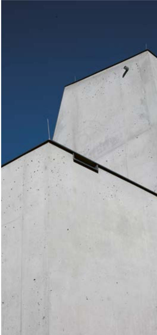
Abb. 80: Äußere Fassade mit unregelmäßig verteilten Lufteinschlüssen.
