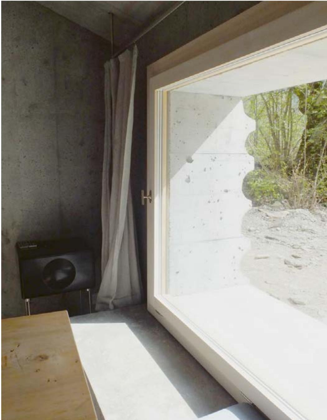
Abb. 92: Innen aufgesetzter Fensterrahmen
