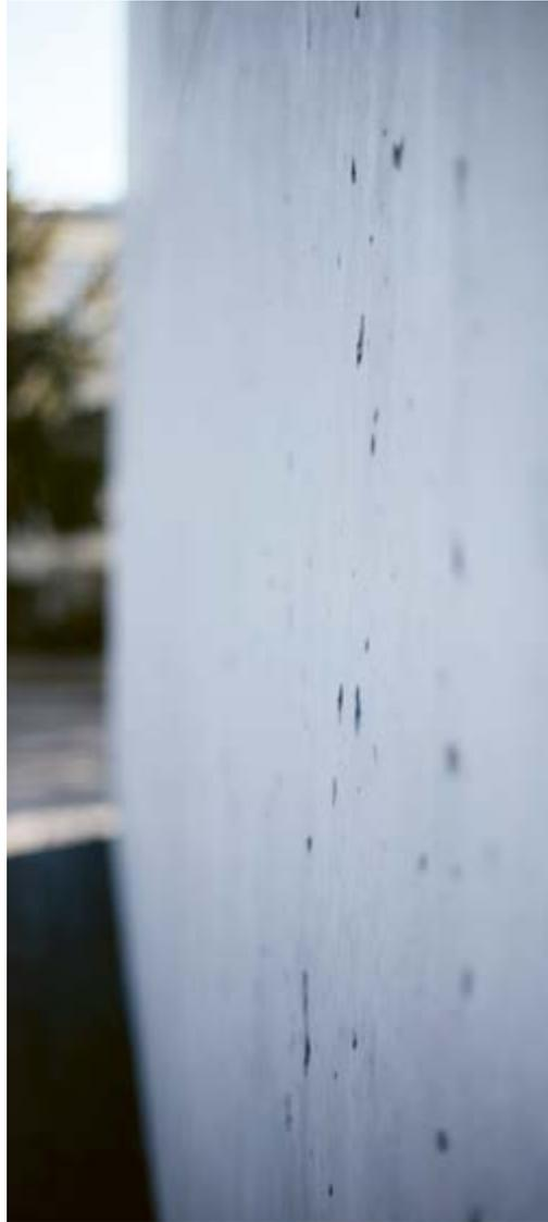
Abb. 81: Lufteinschlüsse charakterisieren die Oberflächenstruktur und brechen die monoton glatte Außenerscheinung.
