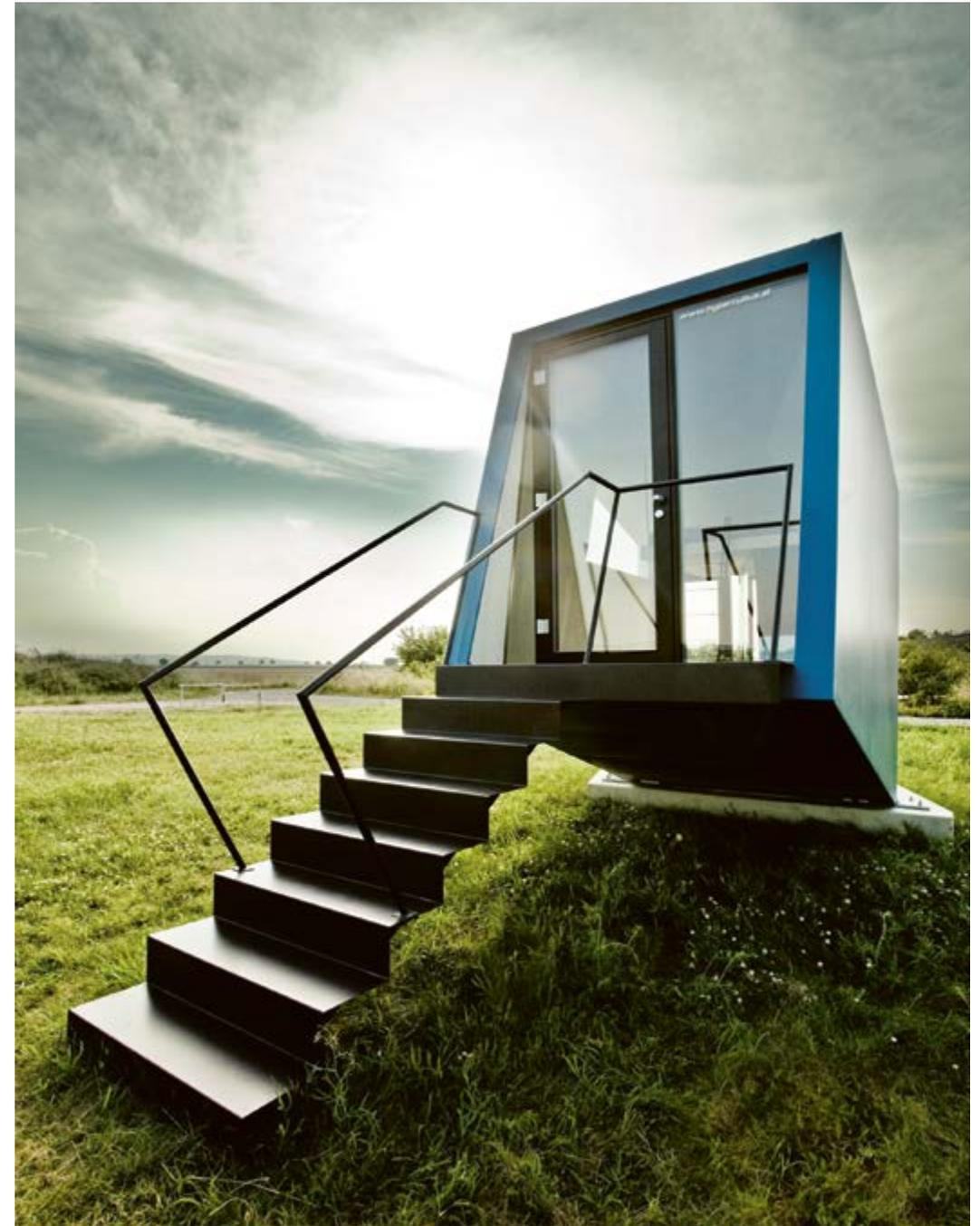
Abb. 10: Der Hyperkubus als mobile Kleinwohneinheit basierend auf einer einschichtigen Brettsperrholzaußenwand
